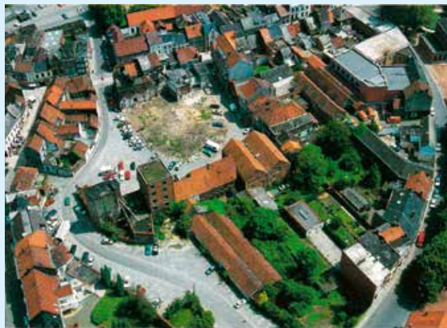
Molenbore voor de renovatie.
